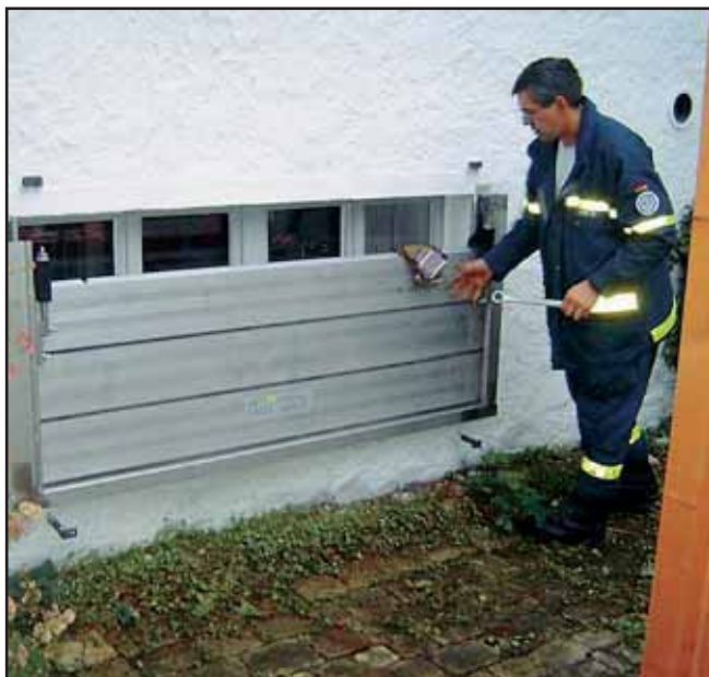
Fenster im Erdgeschoss wird gesichert.
