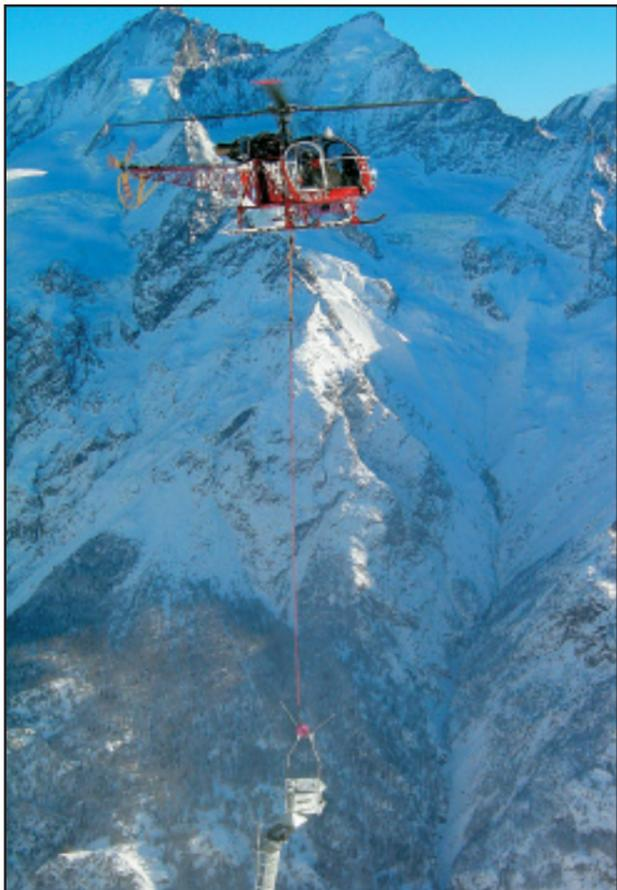
Aufsetzen der Sprengtrommel auf den Masten.
