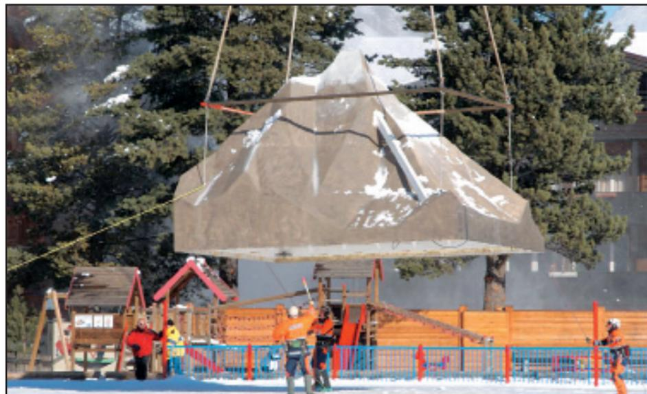
Mit einem Schwerlastenhelikopter wurde das «Matterhörchen» eingeflogen.
