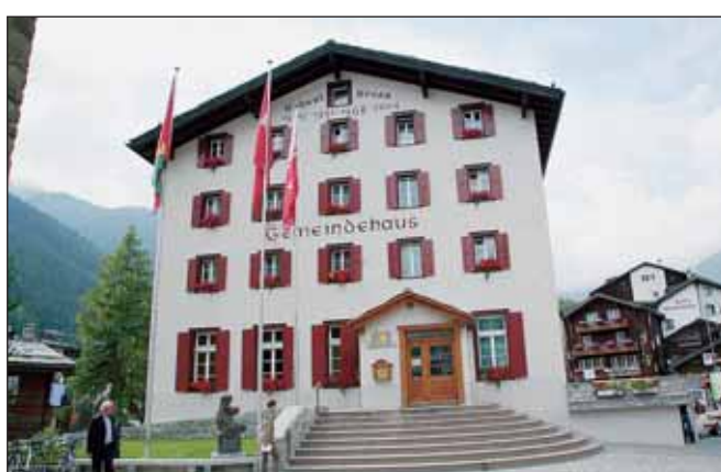
... und nach den abgeschlossenen Umbauarbeiten.
