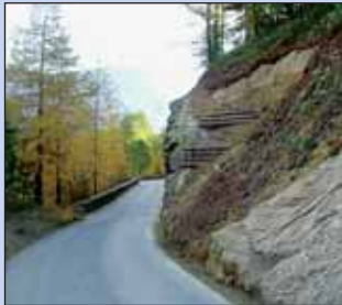
Hang- und Felsicherung Forststrasse Furi-Zmutt.
