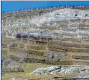
Lawinverbauung Schweiffenen III, 2. Ausbaustappe.
