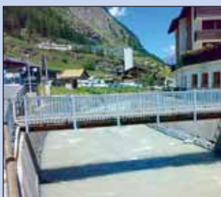
Erstellen von Brückengeländen der Vispa-Überquerungen.
