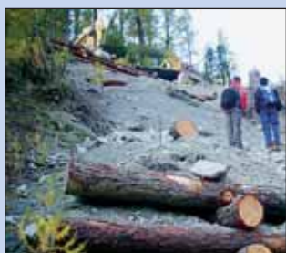
Instandstellung Unwetterschäden Strasse Furi-Stafelalp.
