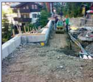
Strassen- und Werkleitungssanierung Schlumattstrasse.
