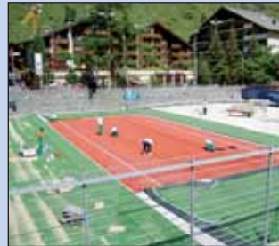
Verlegen des neuen Tennis-kunststoffrasens.
