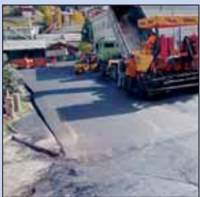
Belagssanierung Sportarena, Oberematten/Kindergarten Schlopfi.
