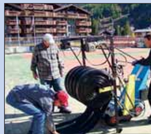
Verlegen der neuen Absorbiermatten Kunsteisbahn.
