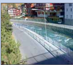
Ersetzen Strassengeländer entlang der Vispa.
