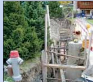
Neubau Kanalisation Wiesti.
