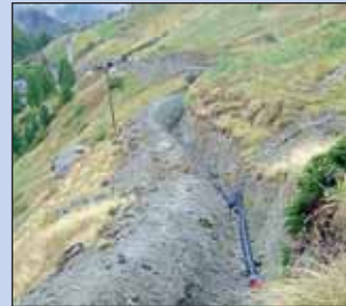
Neubau Kanalisation Mossjensee-Ze Gassu.
