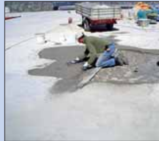
Sanierung Betonplatte Sportarena Oberematten.
