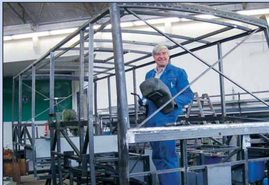
So sieht der Elektrobuss im Rohbau aus.
