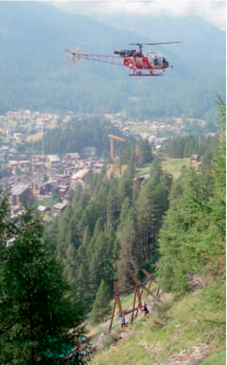
Die ersten Stahlkonstruktionen wurden bereits montiert. Daraus entstehende Lärmbelästigungen sind unvermeidlich.
