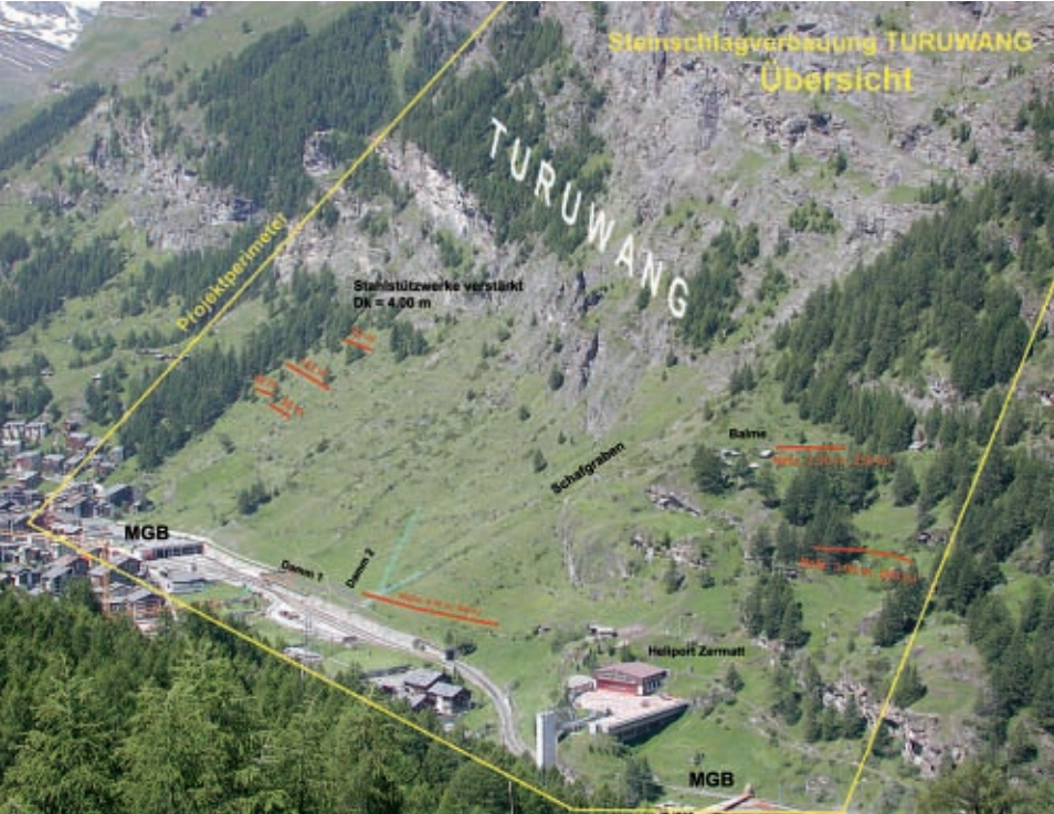
Verschiedene Steinschlagpräventionsmassnahmen werden im Gebiet Turuwang, westlich von Zermatt, realisiert.
