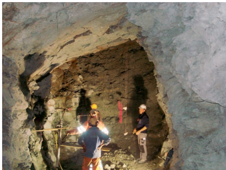
Die Aushubarbeiten für den neuen Zugang zum Restaurant und dem Edelweiss-Shop werden vorangetrieben.
