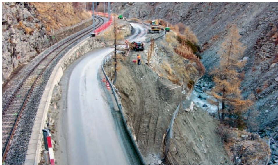
Absenkungsarbeiten im «Lüegelti».
