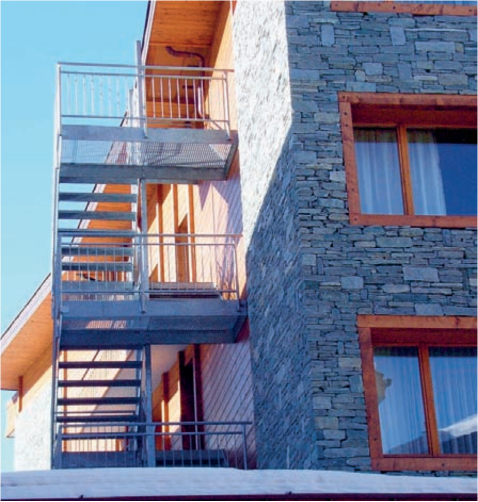
Fluchtwege müssen gut zugänglich sein.
