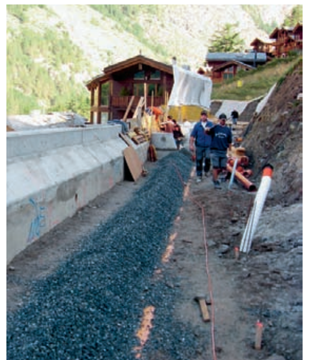
Berg- und talseitige Stützmauern wurden in der zweiten Bauetappe der Erschliessungsstrasse Zer Bännu errichtet.
