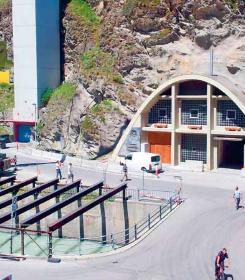
Felspartien zwischen dem Lift Air Zermatt und dem Eingangsportal Kläranlage werden weggesprengt...
