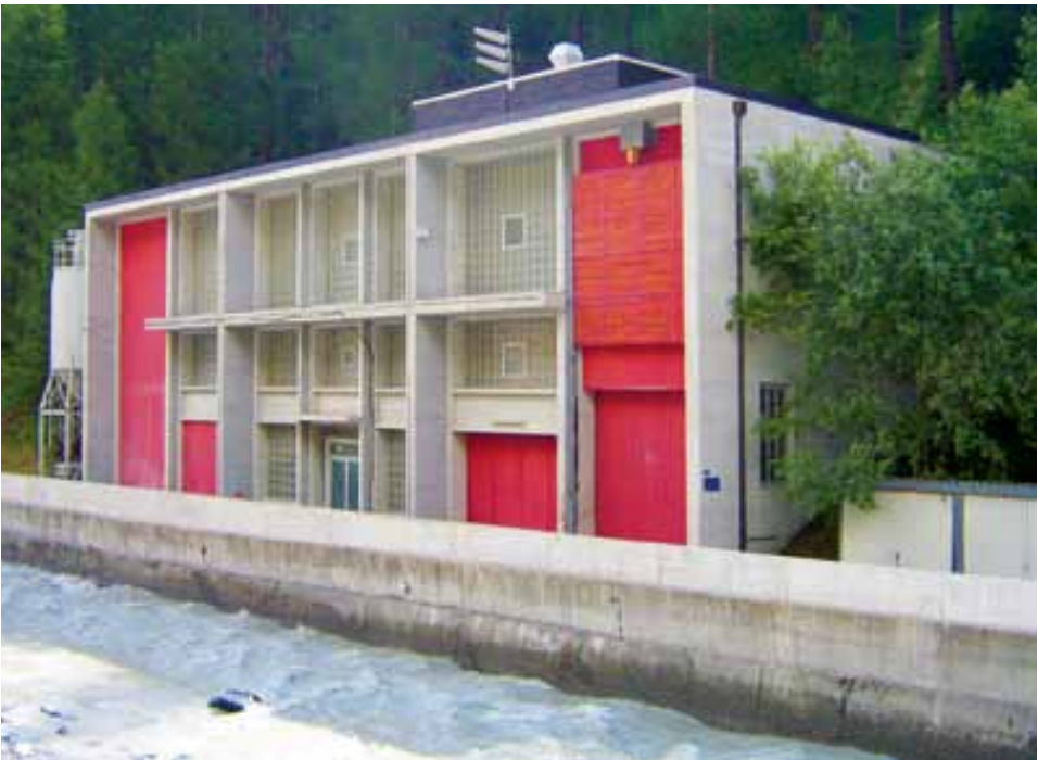
Heutiges Schlammbehandlungsgebäude: Hier stinks – auch zum Himmel.
