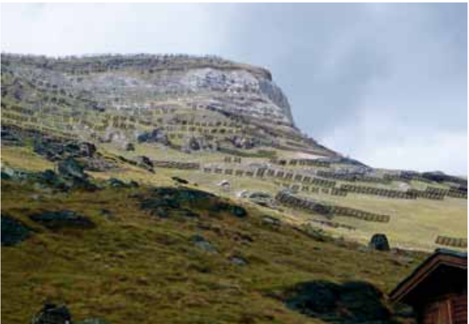
Um die Sonne zur Energiegewinnung zu nutzen, wird nun geprüft, die bestehenden Infrastrukturen der Lawinenverbauungen Schweifinen oberhalb Bahnhof Zermatt zu nutzen und mit Solarzellen auszurüsten.
