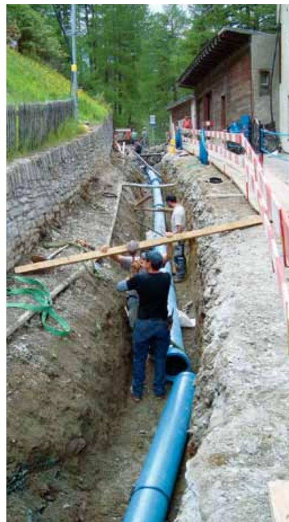
Das Trinkwasser wird aus 93 Quellen gefasst und in rund 42 Kilometer langen Leitungen bis ins Dorf transportiert.
