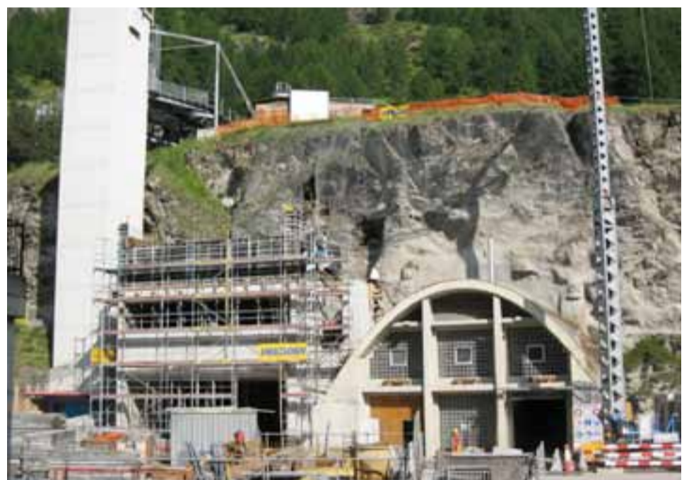
Das Schlammgebäude zwischen ARA-Portal und Lift Air Zermatt.
