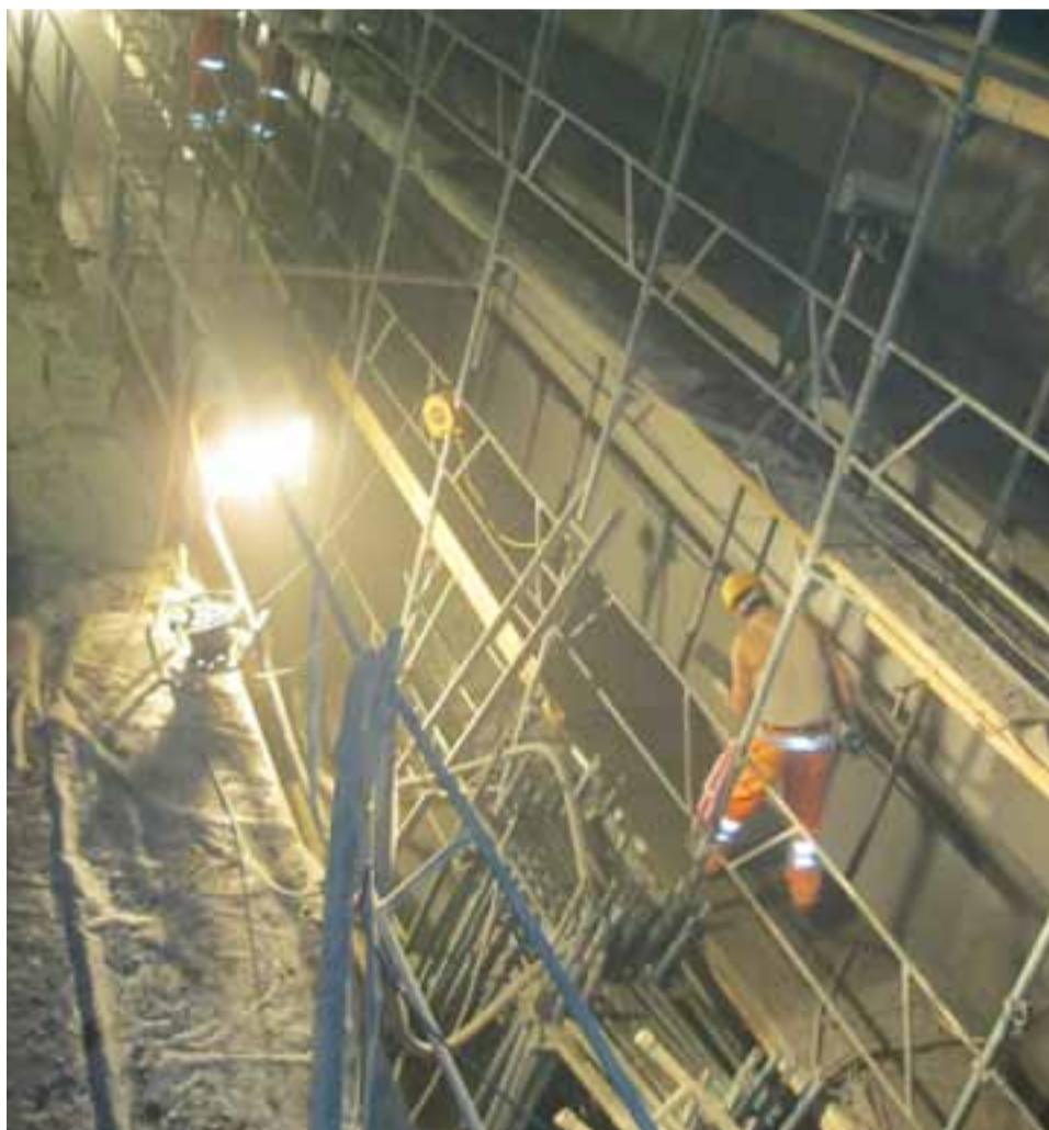
Impressionen von der Baustelle im Berginnern.
