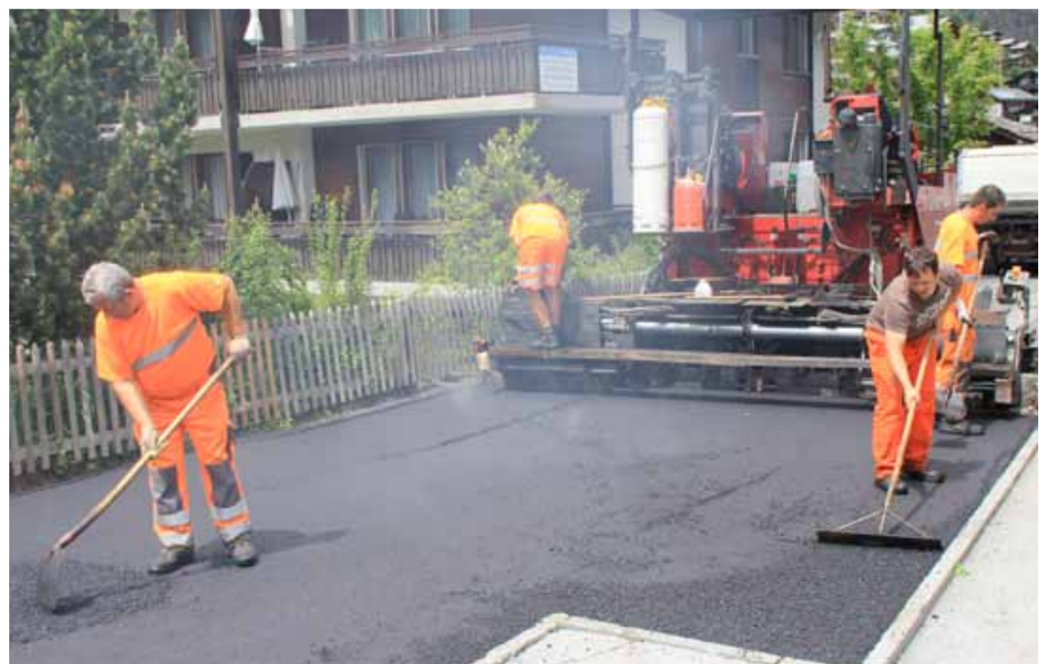
Der Strassenbelag wird in Zermatt täglich auf eine harte Probe gestellt. So umfasst der bauliche Unterhalt auch Belagserneuerungen und das Auswechseln des Strassenoberbaus, was der langfristigen Substanzerhaltung der Fahrbahnen dient.
