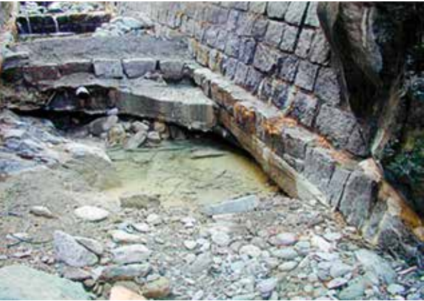
Unterspülte linke Ufermauer. Fels am rechten Ufer verhindert grösseren Kolk. Ufermauer wird auf Felsen fundiert.
