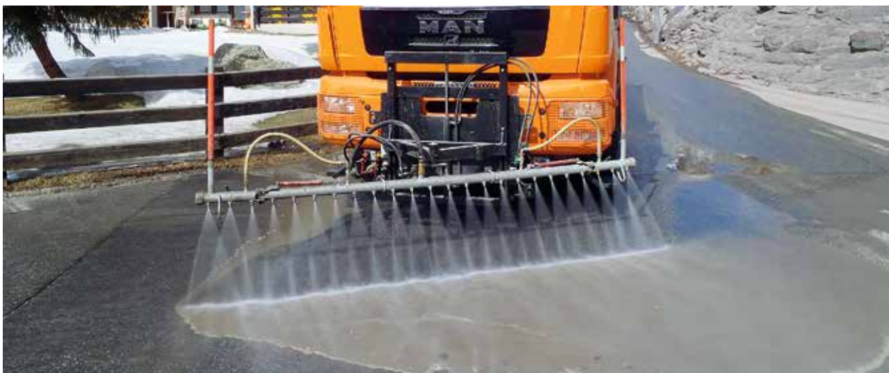
Die Lösung trinkt den Boden und hält ihn ausreichend feucht. So wird der Staub gebunden und der Boden ist vor dem Austrocknen geschützt.
