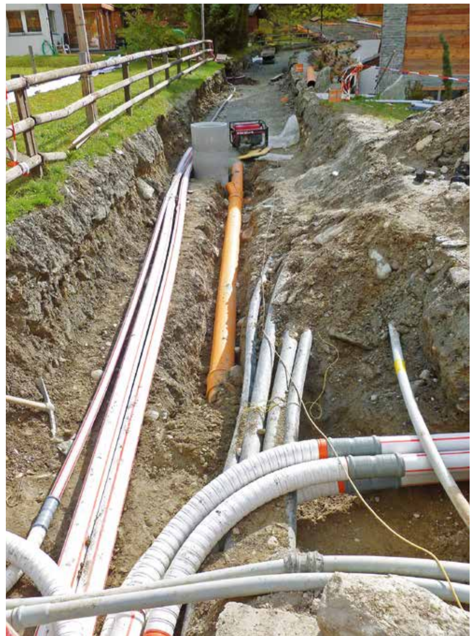
Von September bis November werden in Zermatt verschiedene Bauarbeiten ausgeführt. Es kann zu Behinderungen oder Emissionen kommen.
