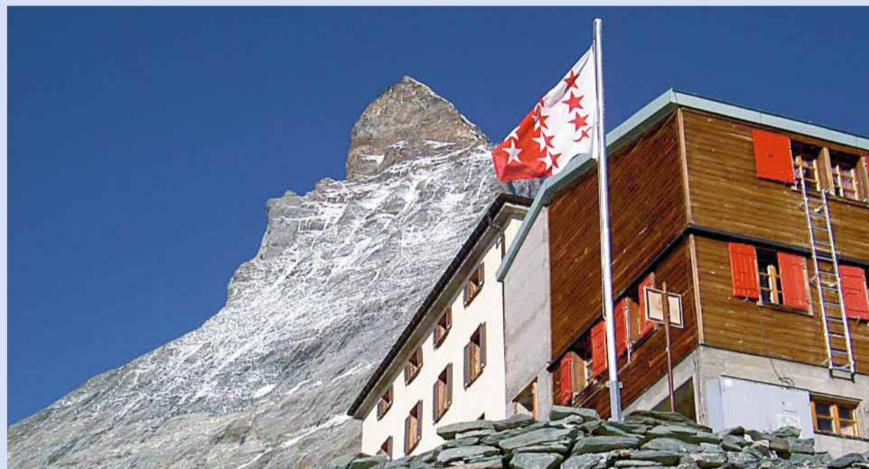
Mit Blick auf das ausserordentliche Jubiläumsjahr zur Erstbesteigung des Matterhorns 2015 hat sich die Burggemeinde Zermatt, zusammen mit der Stiftung «Hörnlihütte 2015», entschieden, die Hörnlihütte zu sanieren und das Berghaus Matterhorn mit einem Umbau den heutigen Anforderungen an Umweltverträglichkeit, Sicherheit, Hygiene und Funktionalität anzupassen.
