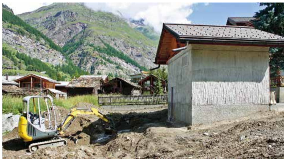
Die Bauarbeiten am neuen öffentlichen Kehrreueunterstand an der Moosstrasse.
