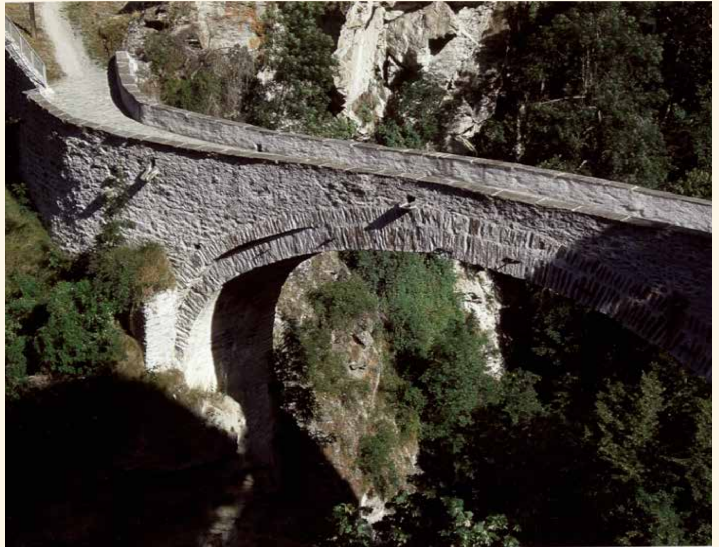
Chibrücke bei Stalden, erbaut von Ulrich Ruffiner 1544/1545
