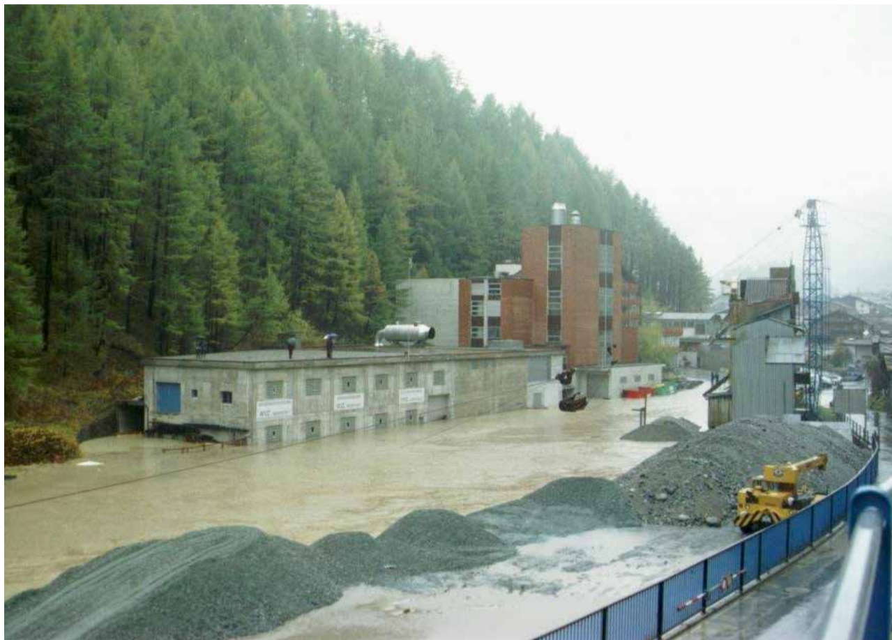
Beim Unwetter von 2000 hat sich der Führungsstab um die Hochwassersituation gekümmert.
