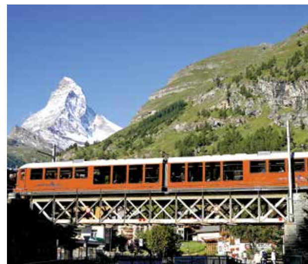
Die alte Getwingbrücke muss ersetzt werden.
