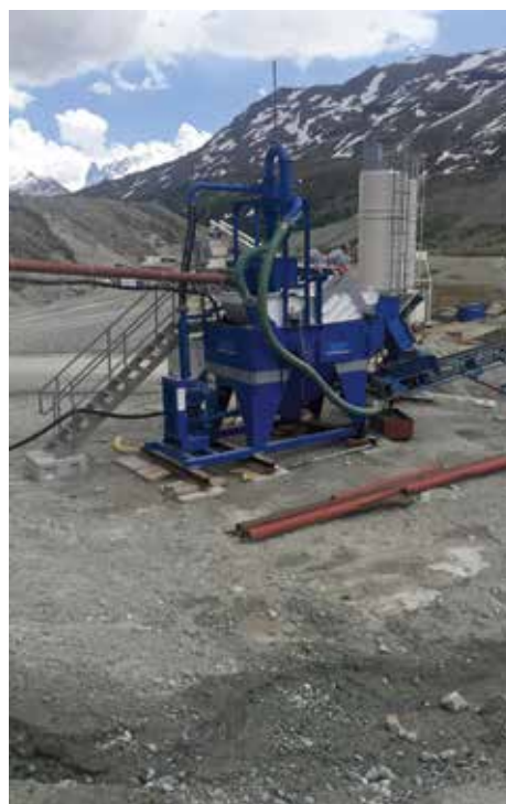
Eine eigens dafür eingerichtete Anlage versorgt die Baustellen mit Beton.
