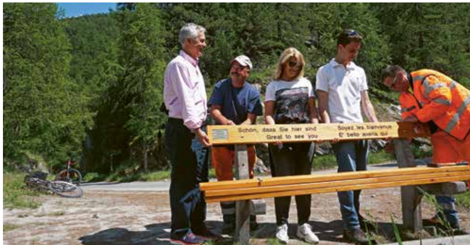
Anfang Juli waren Eduardo, Daniela und Kilian Schindler dabei, als Mitarbeitende der Gemeinde Zermatt die Ruhebänke und das glänzende Familien-Schild montierten.
