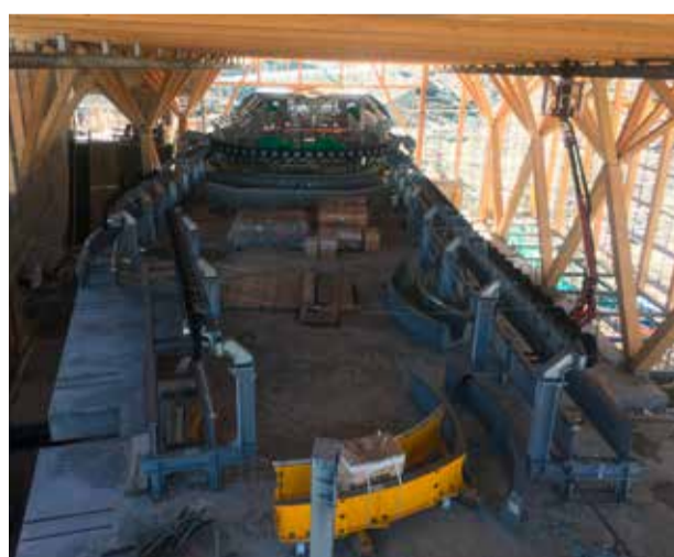
Die Holz-Montagearbeiten in der Talstation sind erfolgreich abgeschlossen worden.
