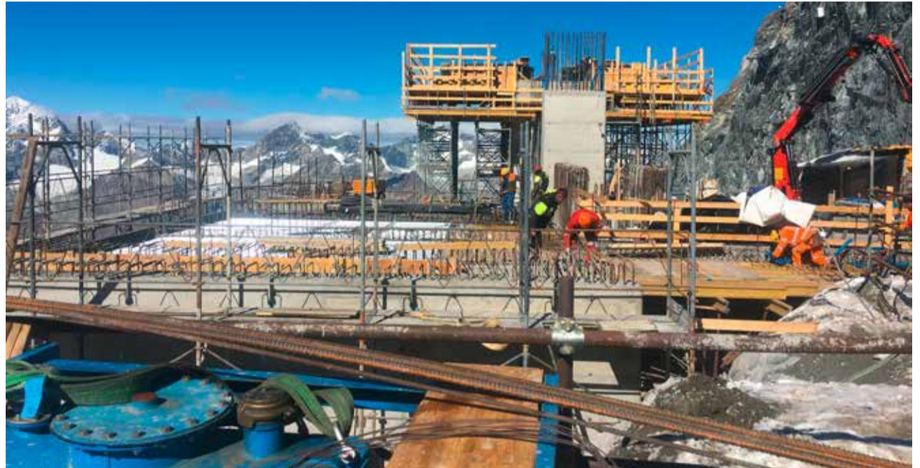
Die Baumeisterarbeiten in der Bergstation sind gut vorangekommen. So steht einem Montagestart für die elektronische Anlage im kommenden Februar nichts mehr im Weg.
