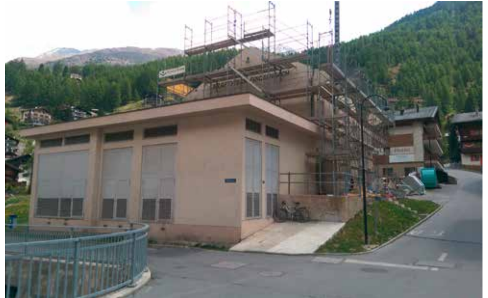
Die Zentrale Wiesti wird derzeit umfangreich saniert. Im Frühjahr 2018 soll der Umbau abgeschlossen sein.
