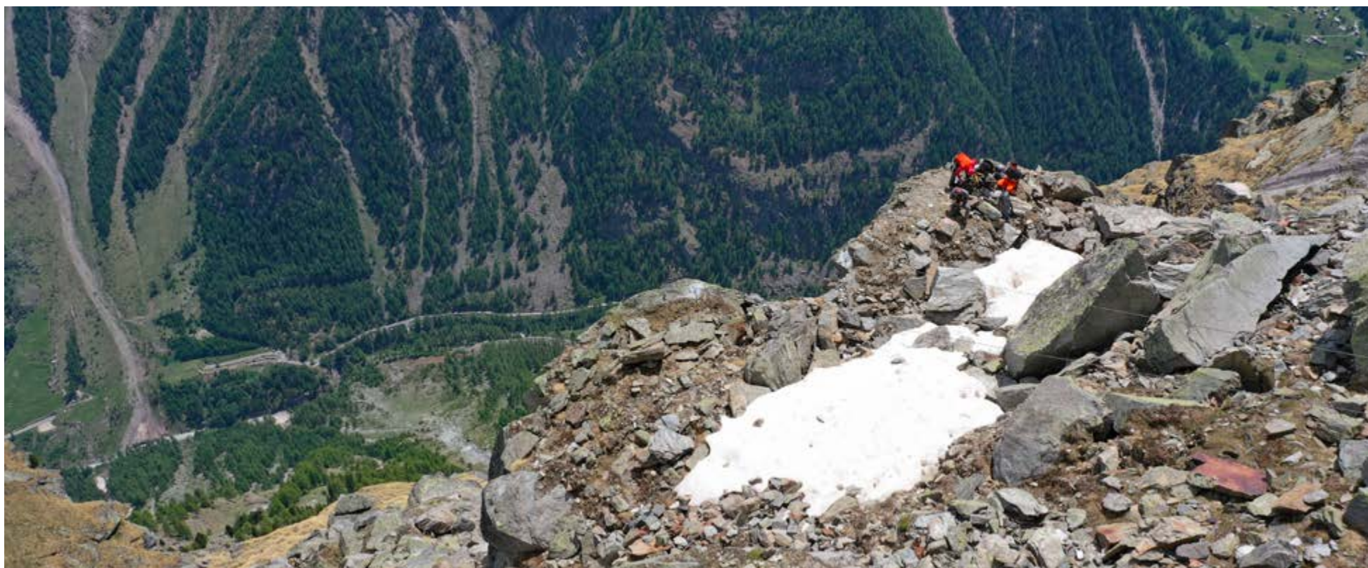
Vorbereitung der Sicherheitssprengung im Gebiet «Kalter Boden»
