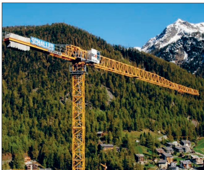
Die Reglementsanpassung sieht vor, dass Baukräne auch während der Wintermonate erlaubt sind.
