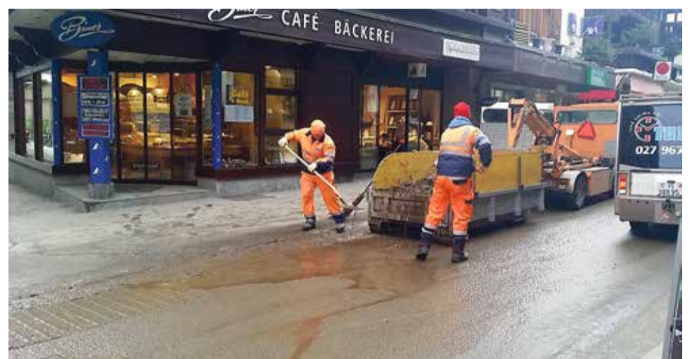
Schnee und Eis sowie Regenwasser auf den Strassen bedeuten jede Menge Arbeit für die Mitarbeiter des Technischen Dienstes in Zermatt.
