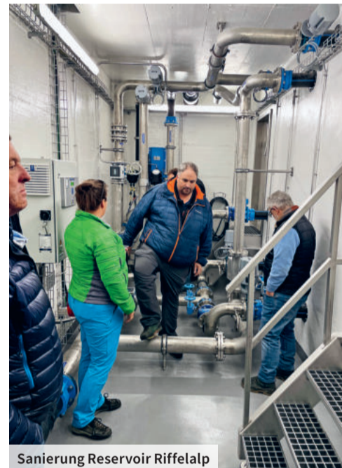
Sanierung Reservoir Riffelalp
