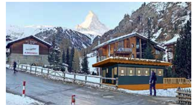
Zwischen Mai und etwa Mitte Juni wird ein Kassenprovisorium aus Containerelementen errichtet.
