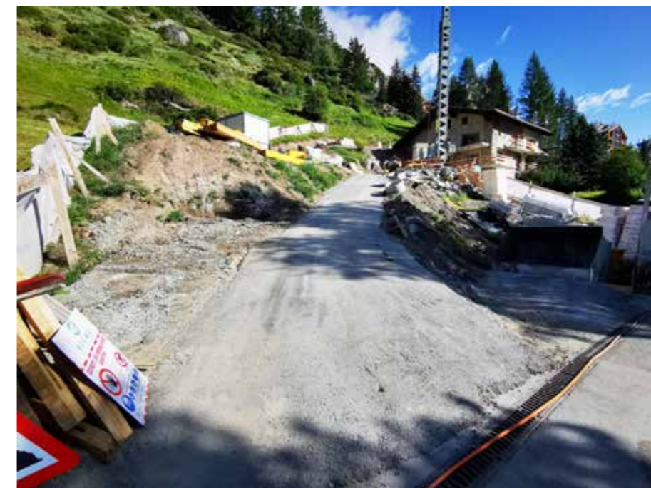
Beispiel Baustellenzufahrt verdichtet Foto: EWG
