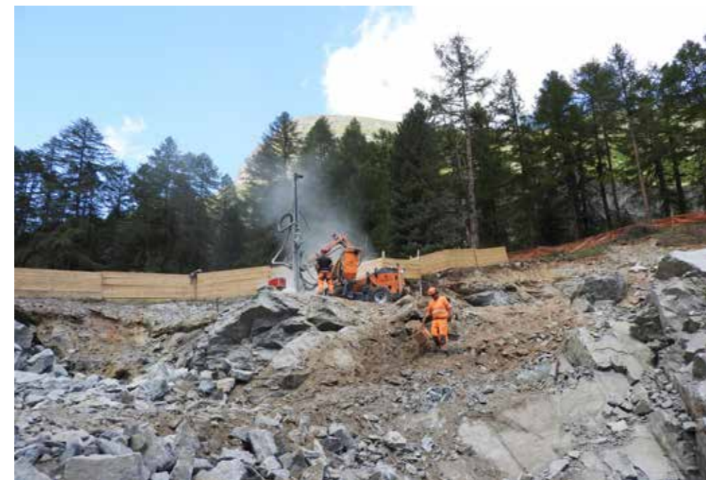
Beispiel Bohrarbeiten Foto: EWG
