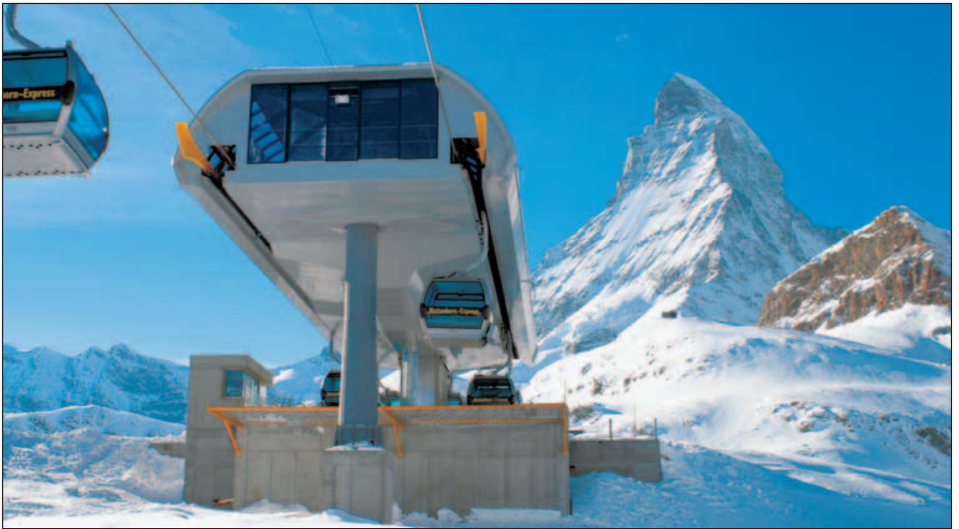
Der neue Matterhorn-Express, seit Ende 2002 in Betrieb, überwindet in 12 Minuten einen Höhenunterschied von 952,5 m und kann pro Stunde 2800 Personen befördern. (Foto: Zermatt Bergbahnen)
