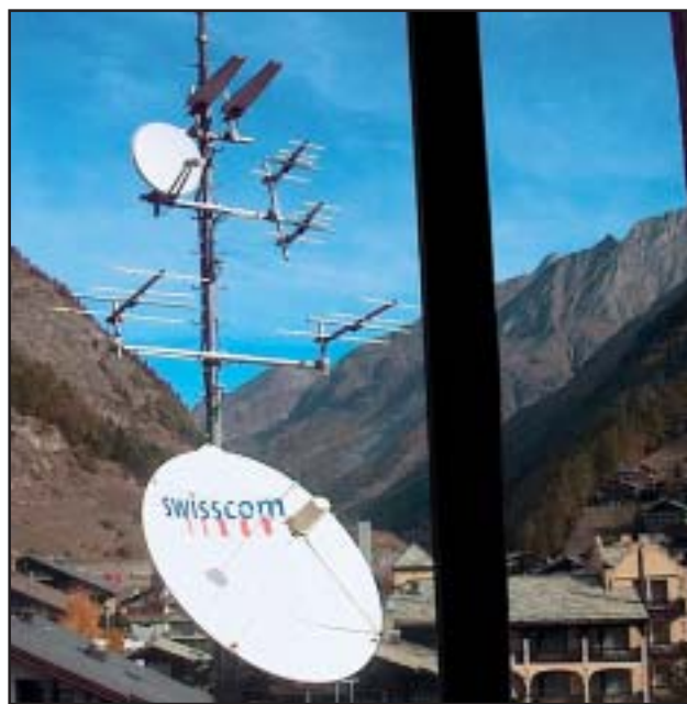
An einem Ort im Wohnhaus Viktoria C wurde der Grenzwert für Orte mit empfindlicher Nutzung, der so genannte Anlagegrenzwert, überschritten.
