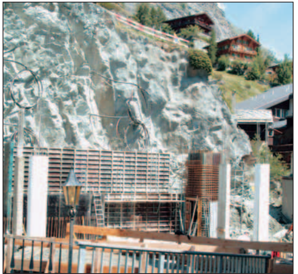
Die Bauarbeiten für das neue EWZ-Gebäude gehen voran: Im nächsten Schuljahr 2005/06 werden hier acht neue Schulzimmer sowie zusätzliche Lehrerzimmer zur Verfügung stehen.
