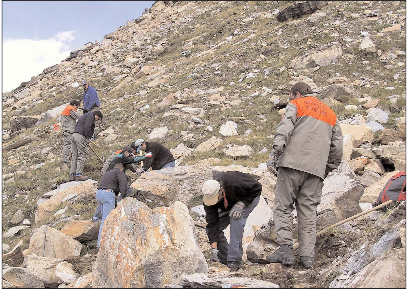
Mitglieder der ZSO Zermatt bei der Instandstellung eines Wanderweges im Gebiet Rothorn.
