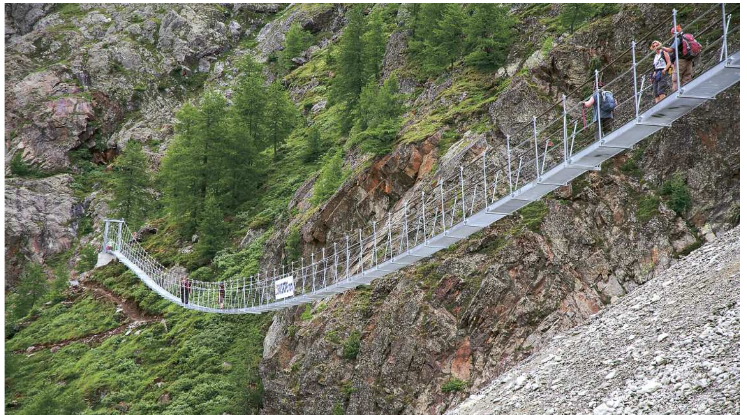
Dank der neuen Hängebrücke ist der Europaweg nun wieder auf seiner ursprünglichen Route durchgehend begehbar.
