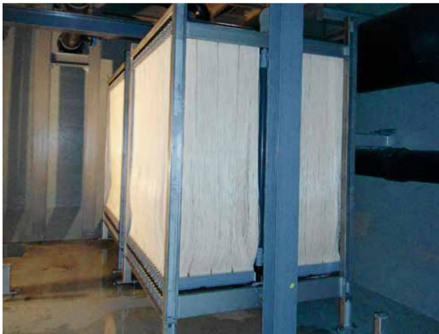
Membrankassetten im Membranfiltrationsbecken installiert.
