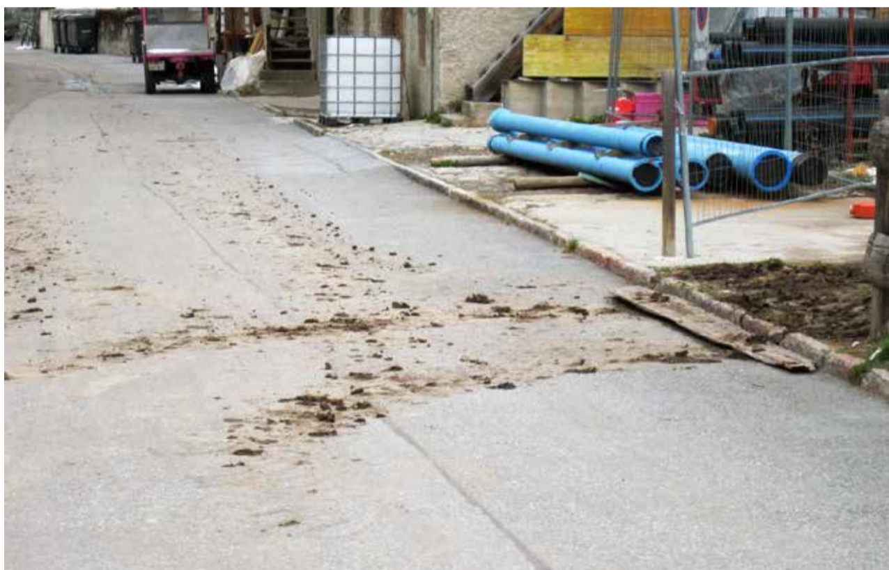
Verschmutzte Strasse verursacht durch die Ausfahrten einer Baustelle.
