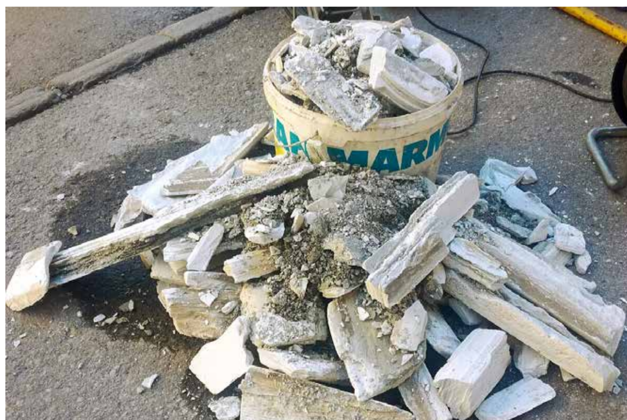
Entnommene Ablagerungen in den Abwasserleitungen, welche durch nicht fachgerechte Entsorgungen entstanden sind.
