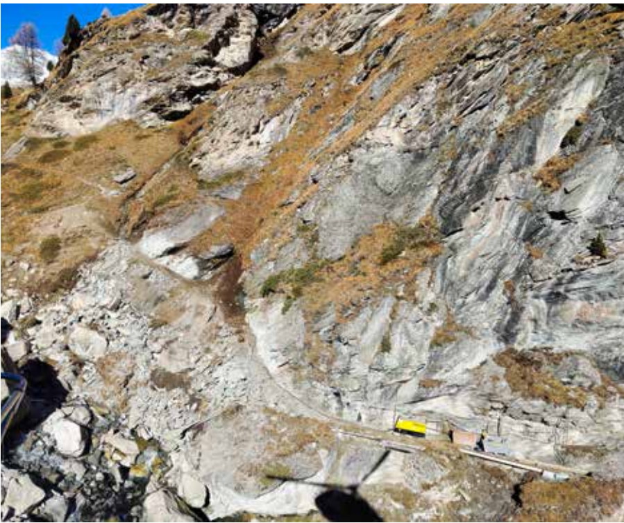
Bereits ausgeführte Massnahmen (Wegverlegung) unterhalb von Trift
